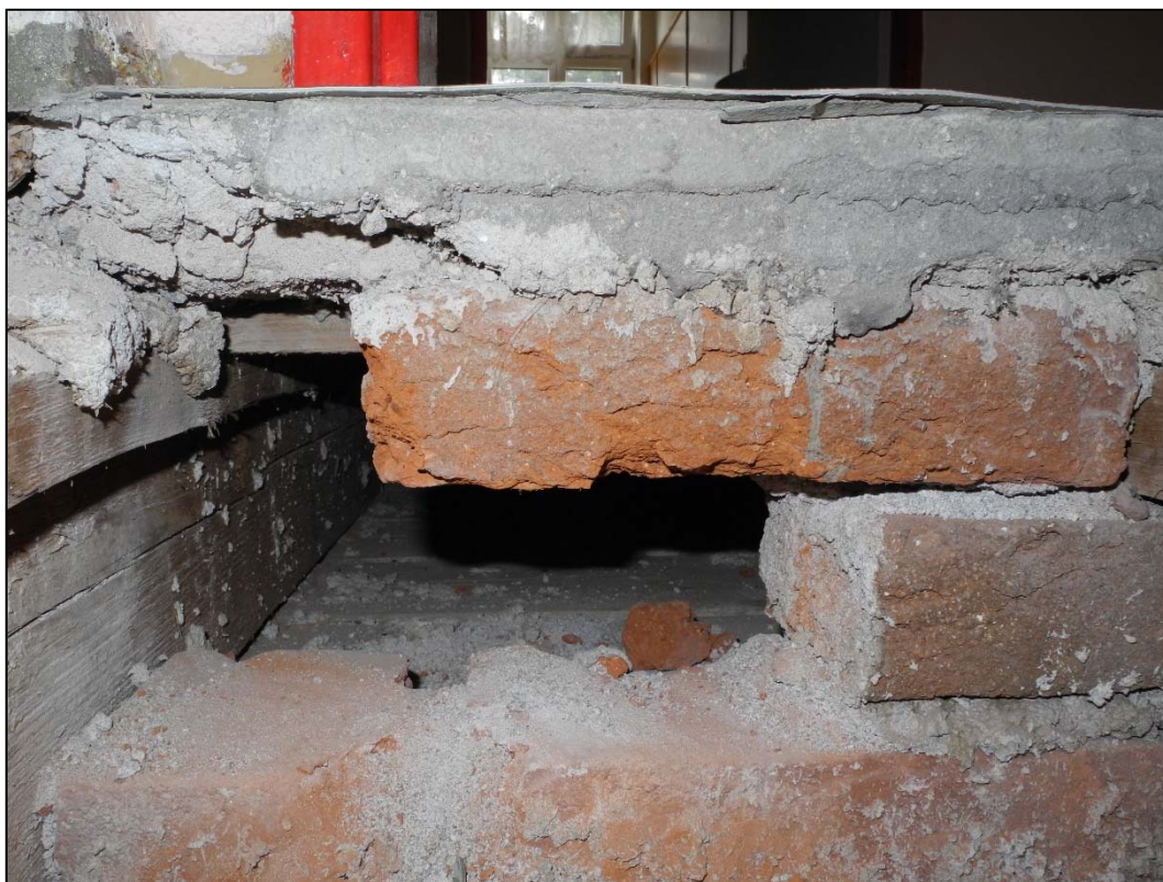
Foto 15 Pohled na sondu S3 – vnitřní dělicí stěna – trámy pokračují i přes prostor chodby
