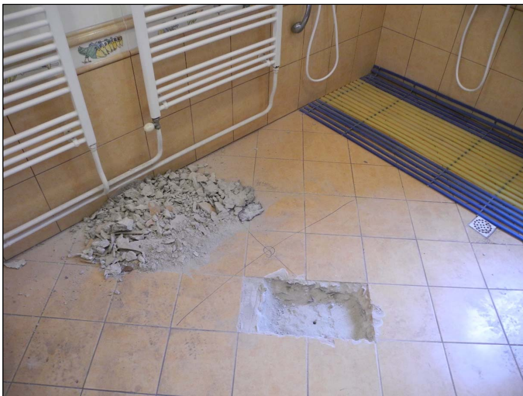
Foto 23 Celkový pohled na sondu S7 – místnost 2.12 – železobetonový strop tl. 125 - 130 mm
