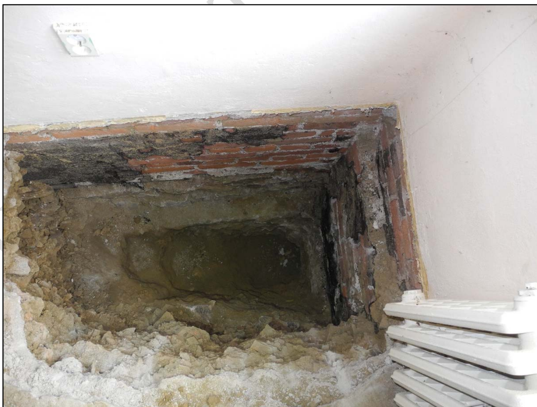
Foto 10 Celkový pohled na kopanou sondu S1 do hloubky cca - 2,120 od podlahy, na obvodové a vnitřní stěně viditelná hydroizolace (typ izolace IPA)
