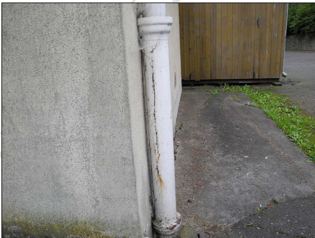
Foto 64 Detail porušeného litinového svodu v severovýchodním rohu objektu
