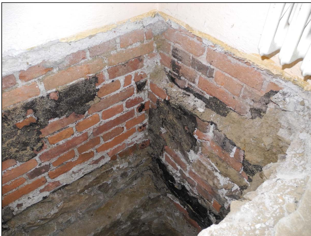
Foto 11 Celkový pohled na kopanou sondu S1 do hloubky cca - 2,120 od podlahy, na obvodové a vnitřní stěně viditelná hydroizolace (typ izolace IPA), hydroizolace ukončena pod úrovní betonové mazaniny
