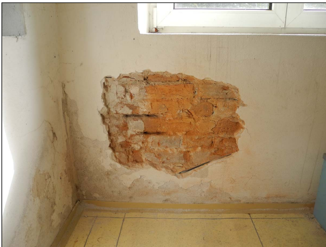
Foto 37 Celkový pohled na sondu Z4 – místnost 1.07 – na stěně patrná vlhkostní mapa – jihovýchodní roh objektu
