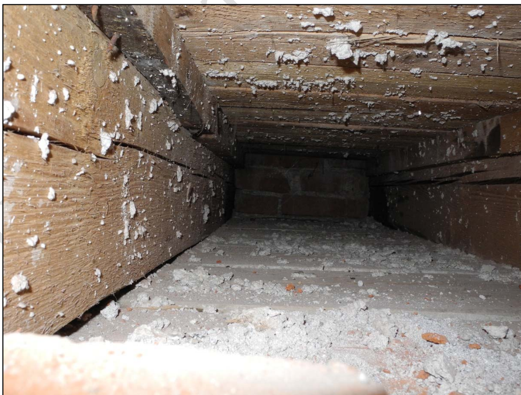
Foto 16 pohled na uložení trámů na severní stěně objektu – podlahové trámy špinavé od betonáže mazaniny ve skladbě podlahy
