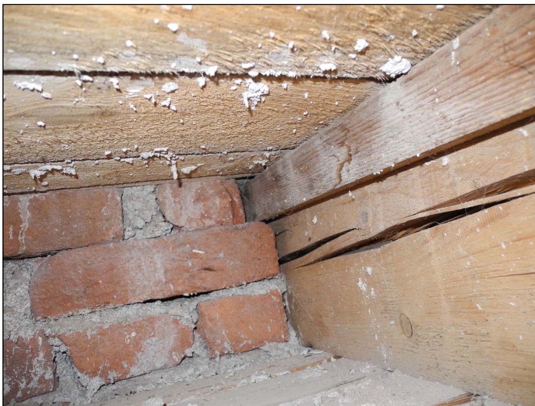
Foto 13 Detail uložení trámu podlahy na vnitřní zdivo
