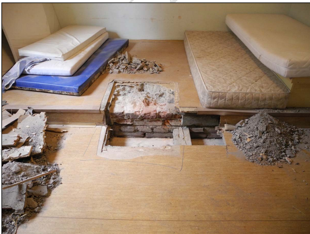
Foto 24 Celkový pohled na sondu do stropu S8 v místnosti 3.05 – nižší část tvořena dřevěným trémovým stropem, trávy rozměru 175 x 240 mm s osovou vzdáleností cca 1,03 m; vzdálenější část tvořena ŽB deskou tl. 100 mm
