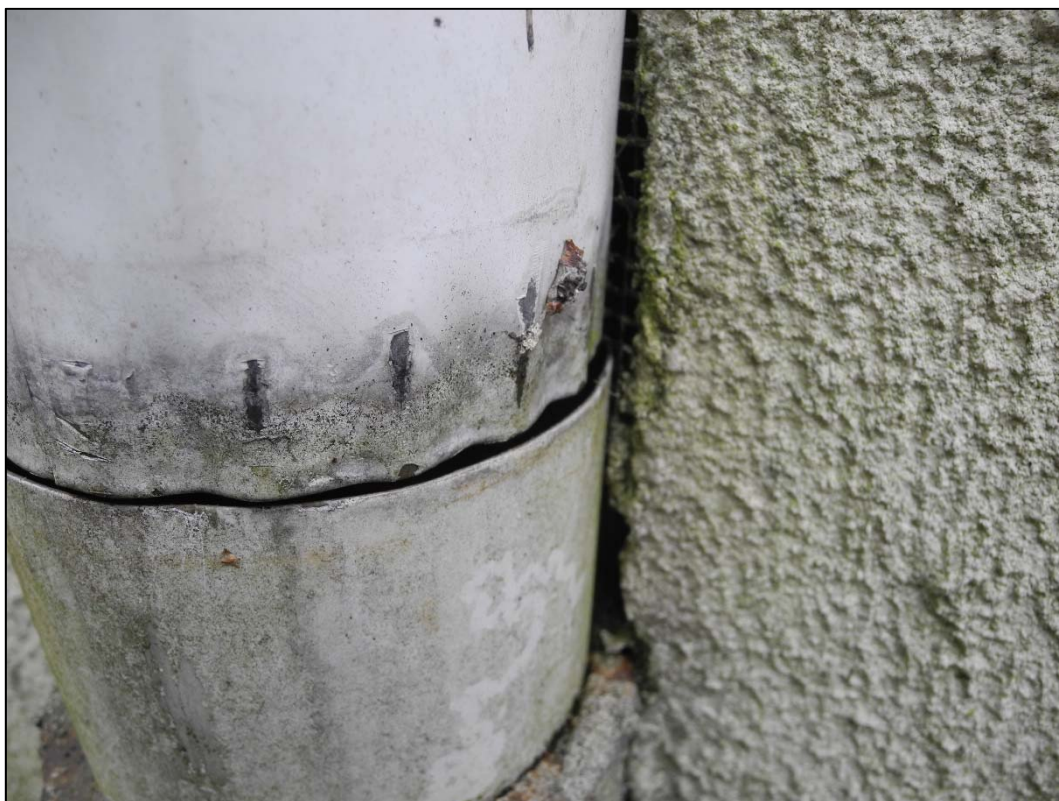
Foto 61 Detail napojení svodu ze střechy u severozápadního rohu objektu
