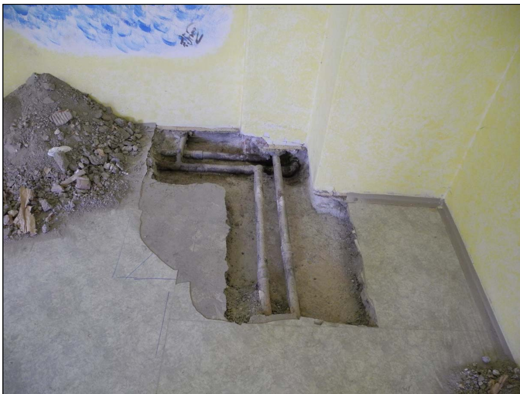
Foto 17 Celkový pohled na sondu S4 – místnost 2.17 – železobetonový strop tl. 90-95 mm
