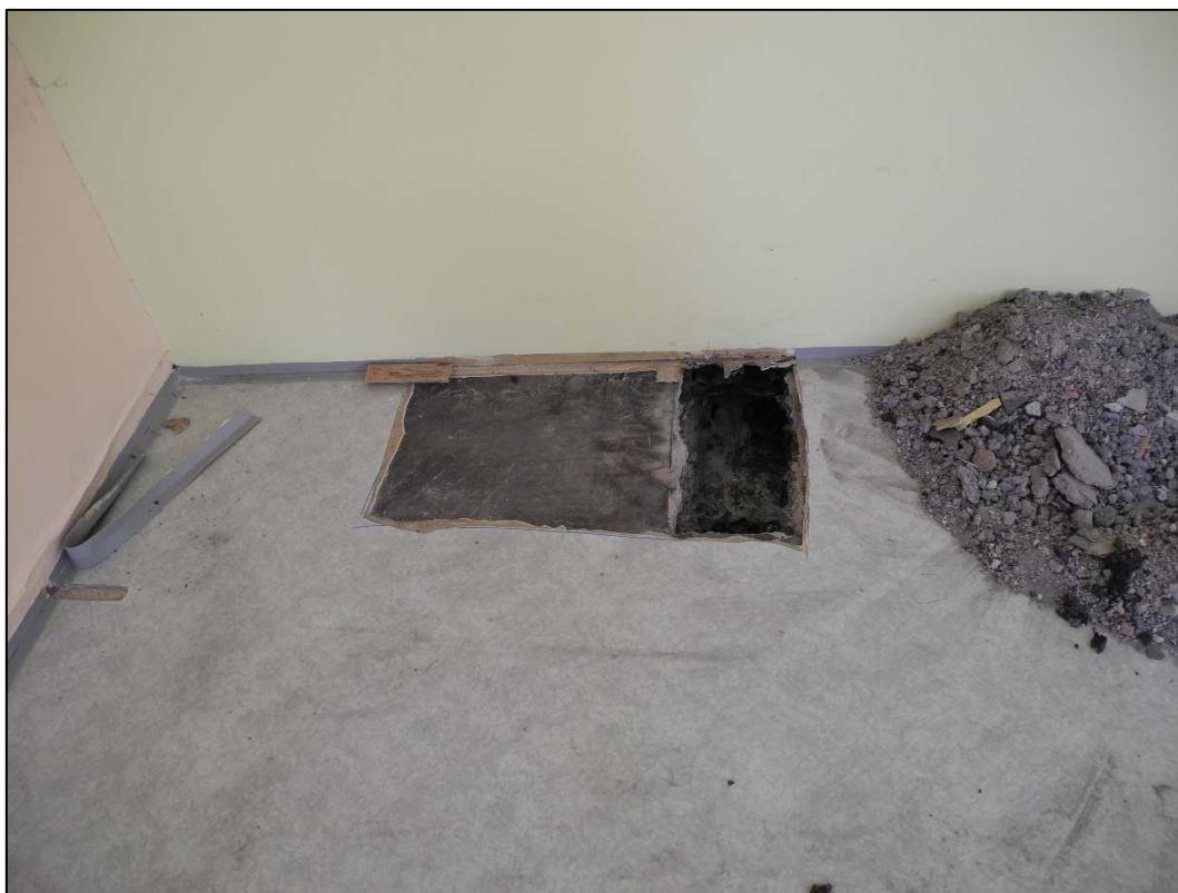
Foto 19 Celkový pohled na sondu S6 – místnost 2.15 tělocvična – železobetonový strop tl. 90 mm
