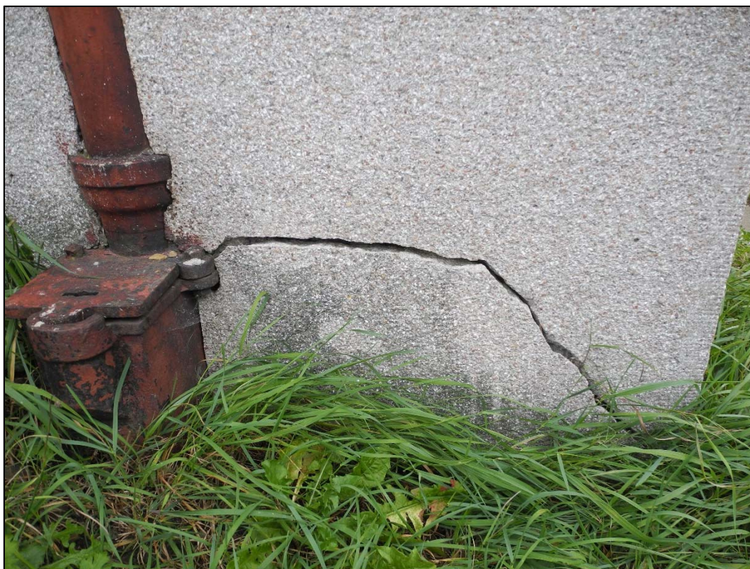
Foto 59 Detailní pohled na ukončení svodu ze střechy v jihozápadním rohu objektu
