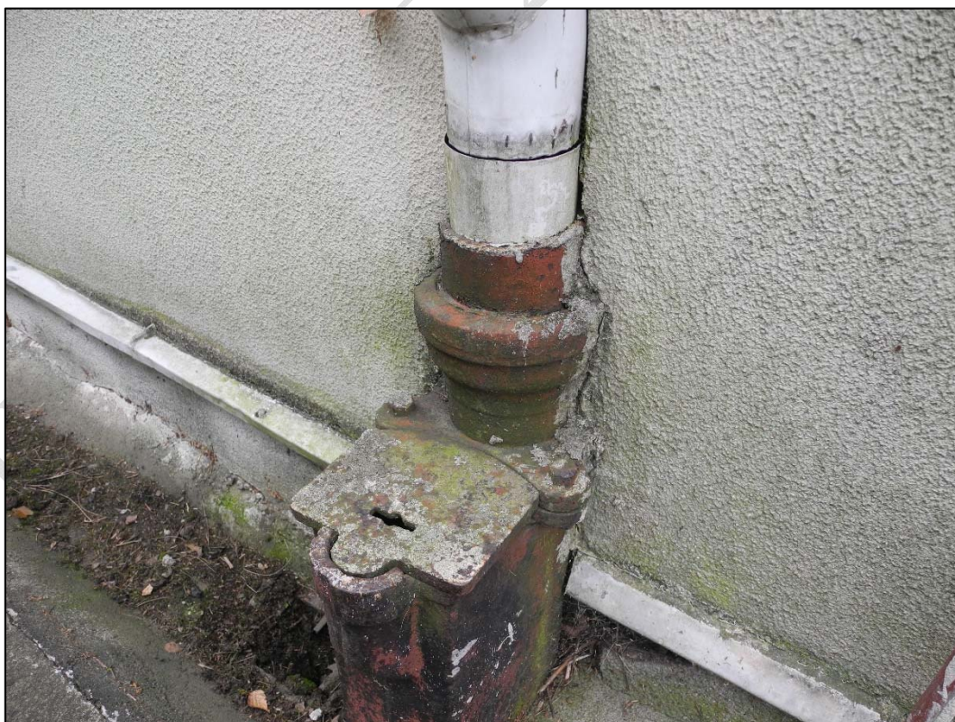
Foto 60 Detail svodu u severozápadního rohu objektu – okapový žlábek podél severní stěny a vtok zaneseny
