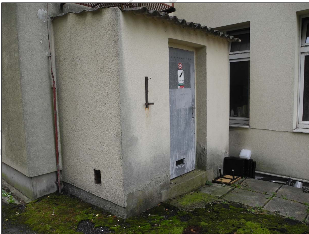
Foto 62 Celkový pohled na technickou místnost na severní části objektu – chybějící dešťové svody a okapy u střechy s eternitovou krytinou – stékající voda způsobuje degradaci omítky ve spodní části objektu
