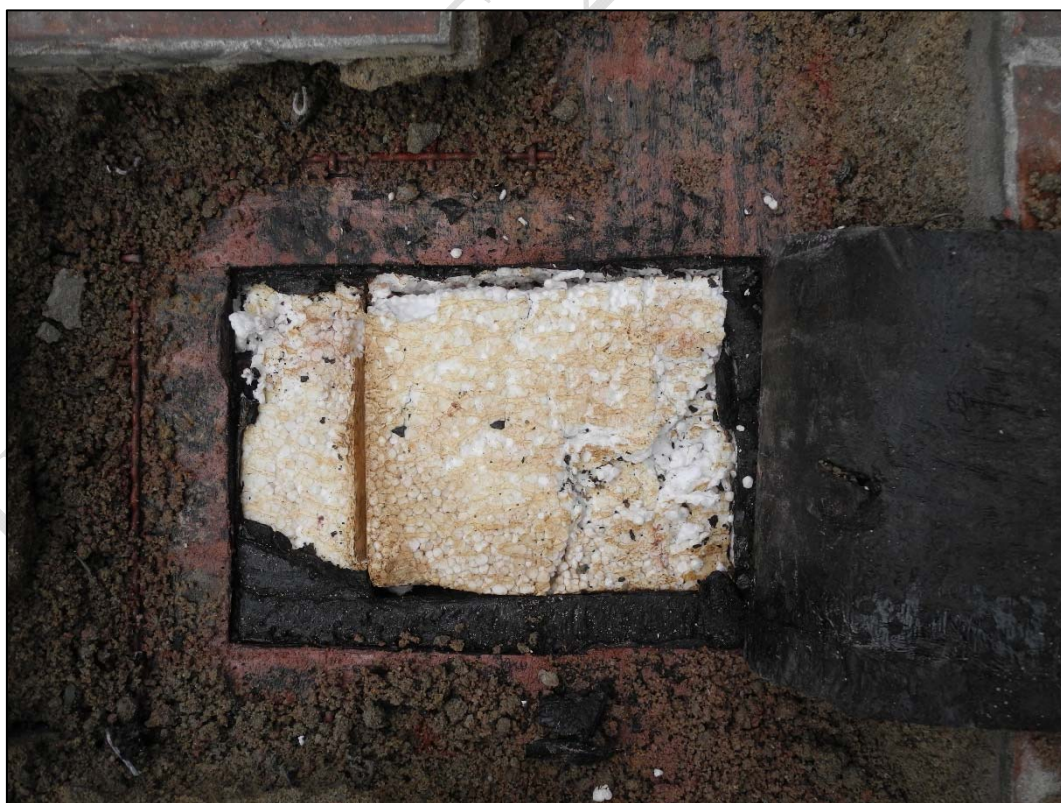
Foto 28 Skladba S10 – odkrytá tepelná izolace která byla položena na vrstvě izolace a dále na ŽB desce nad saunou
