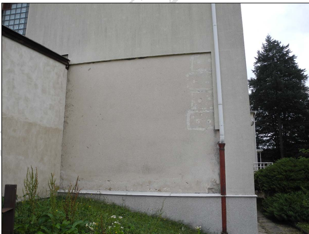
Foto 58 Celkový pohled na jihozápadní roh objektu – nad soklem patrná degradace omítky
