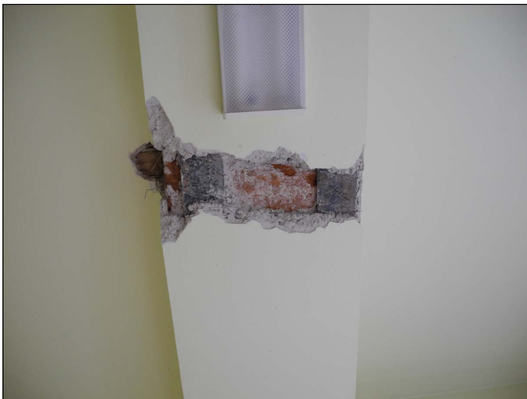
Foto 25 Celkový pohled na spodní část trámu tvořeného ze 2 válcovaných profilů s cihelnou vyzdívkou
