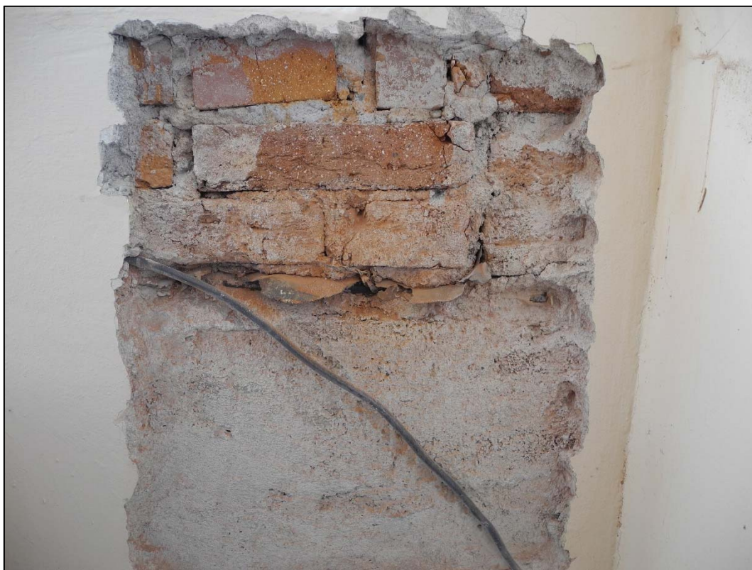
Foto 53 Detailní pohled na sondu Z11 v místnosti 3.20, betonový parapet se zbytky hydroizolace s nadezdívkou
