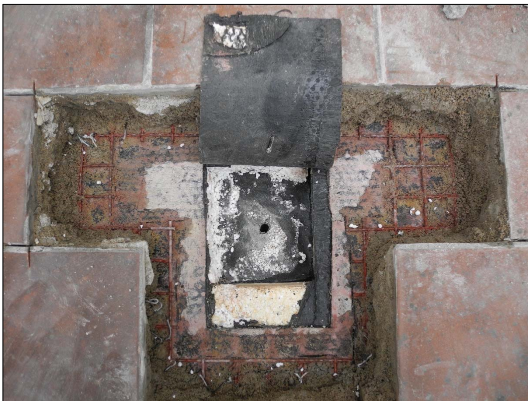
Foto 29 Skladba S10 – odkrytá tepelná izolace která byla položena na vrstvě izolace a dále na ŽB desce nad saunou
