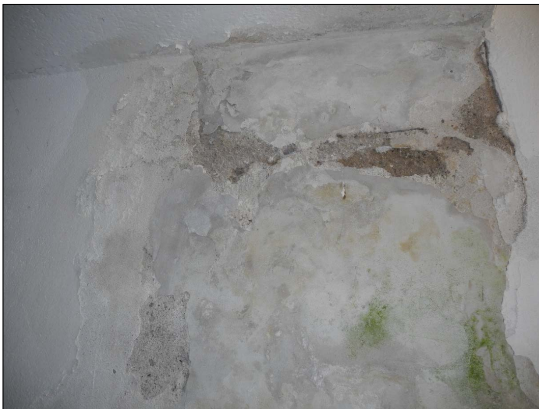
Foto 55 Detailní pohled na vstupní chodbu do sauny – na pravé stěně výrazná vlhkostní mapa a výkvěty solí
