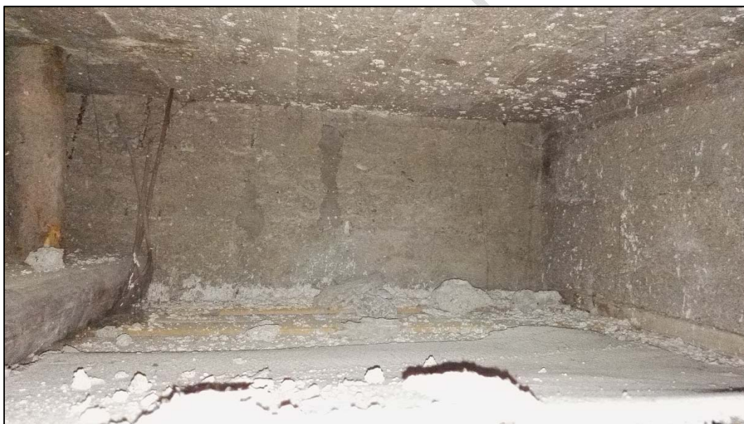
Foto 22 Detailní pohled na sondu S6 – čelně ŽB průvlak rozměru cca 270 x 570* m včetně povrchové úpravy, trámy viditelné i v místnosti 1.13, osová vzdálenost cca 3,3m; vpravo viditelný ŽB trám rozměru 145 x 300* mm s osovou vzdáleností cca 900 mm; * výška měřená pod ŽB deskou
