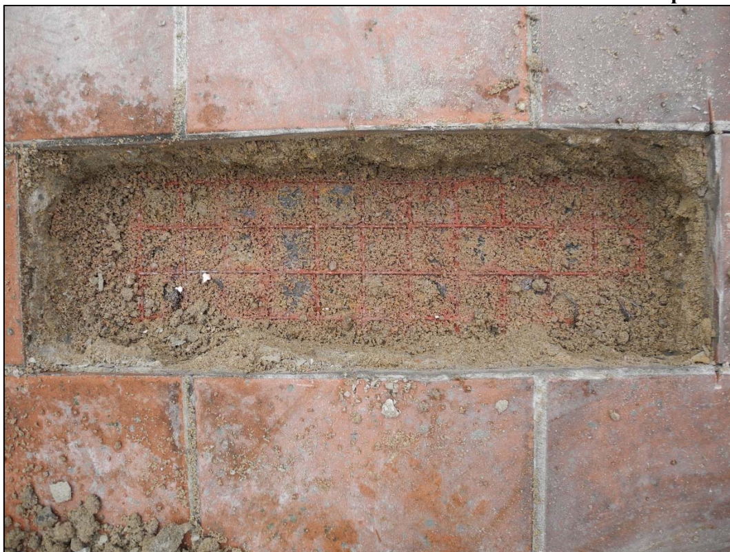
Foto 27 Pohled na sondu S10 umístěné na terase po odstranění dlažby a betonové mazaniny. Jako výztuž použito pletivo
