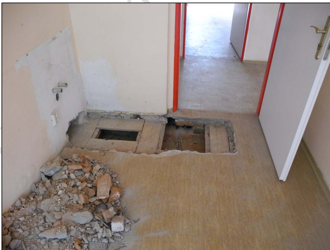
Foto 14 Celkový pohled na sondu S3 po vybourání podlahy a odstranění záklopu
