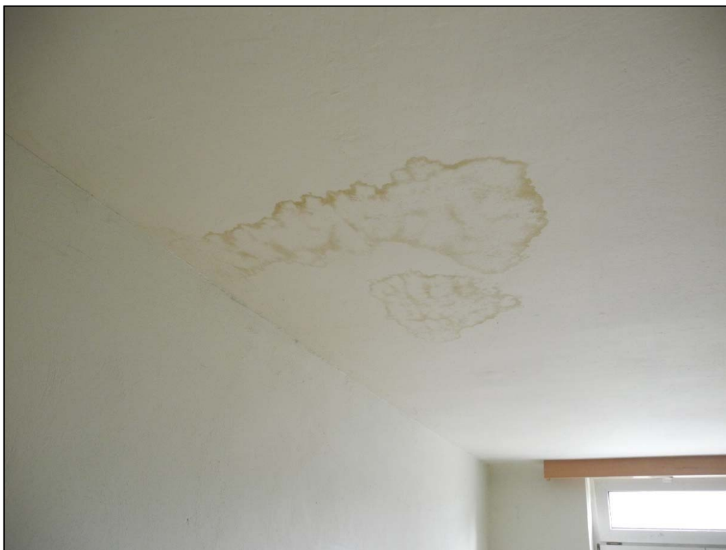
Foto 47 Pohled na strop v místnosti 3.03 – patrná vlhkostní mapa od zatékání střechou
