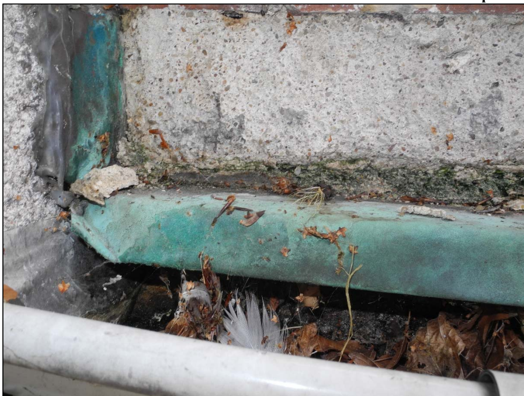
Foto 57 Detailní pohled na ukončení oplechování ploché střechy v místě okapu, který je zanesen listím apod.
