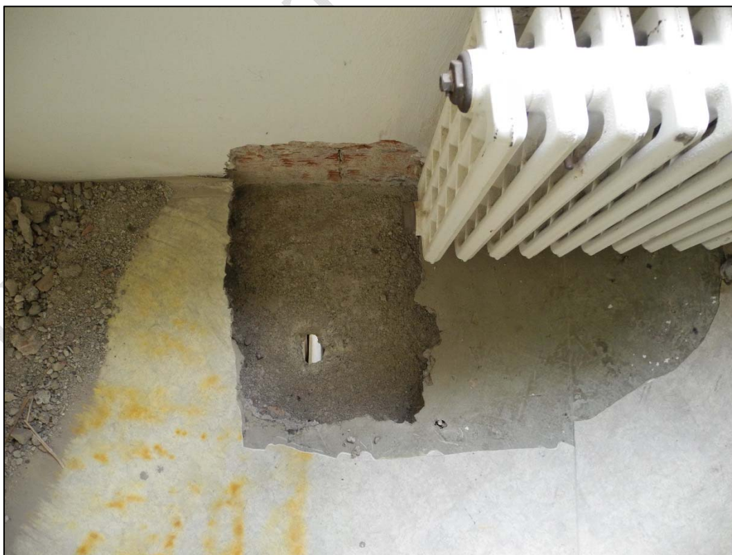
Foto 18 Celkový pohled na sondu S5 – místnost 2.18 – železobetonový strop tl. 85-90 mm
